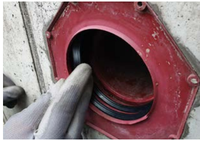
2. Lippendichtringe einsetzen.
