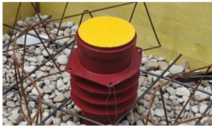
Einrichten auf Oberkante Fundamentplatte
